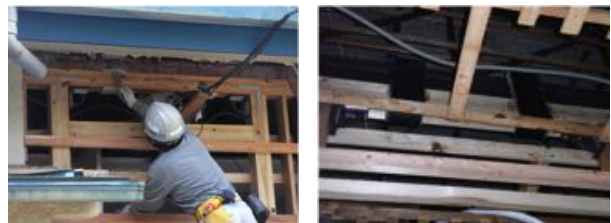
施工事例（枚方市）
