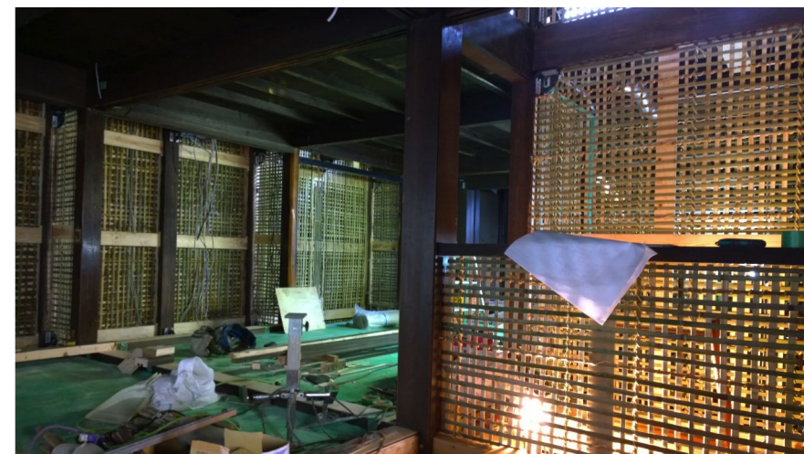
土壁の施工 (愛媛県)
