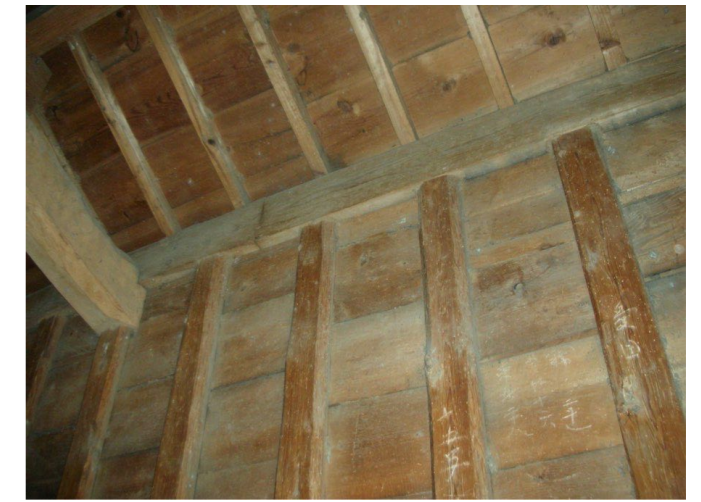
落とし込み板壁（宮城県・米蔵）
