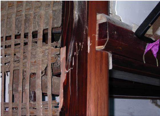
小壁直下で破損した柱
