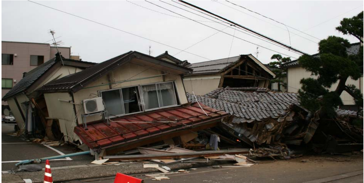
写真3 新潟県中越沖地震の被害（柏崎市内）
