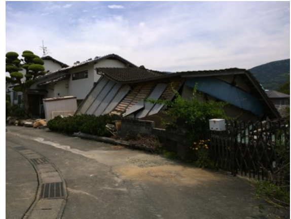
写真5 液状化噴砂跡と倒壊住宅
