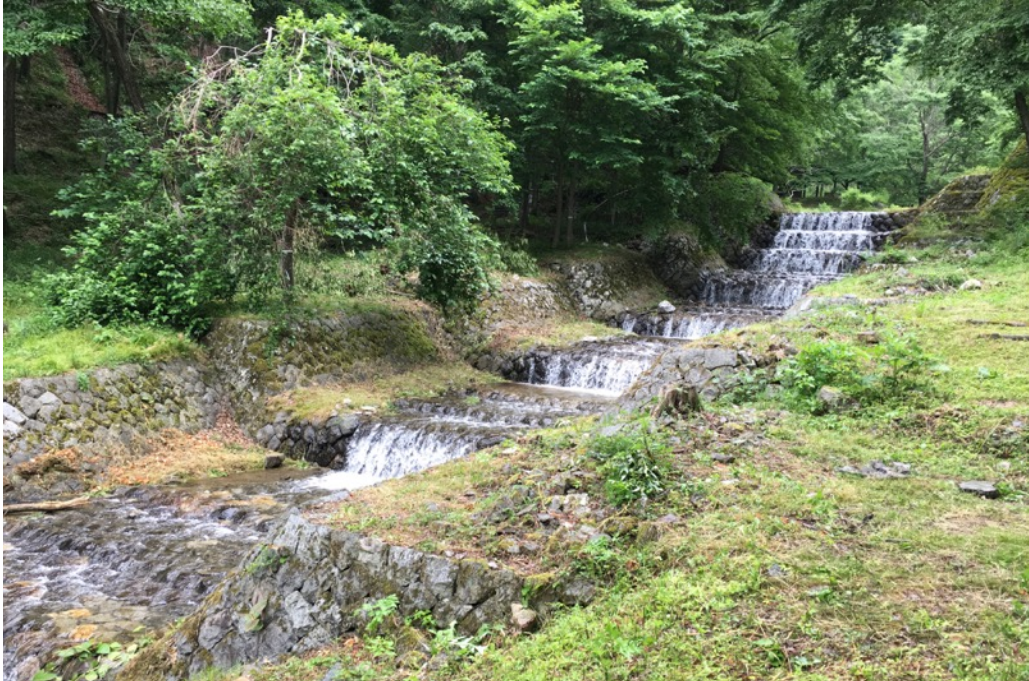
写真42 長野の砂防施設（牛伏川フランス式階段工）
