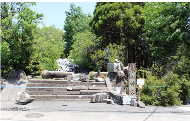
写真8 鳥居・階段・拝殿の倒壊した木山神宮
