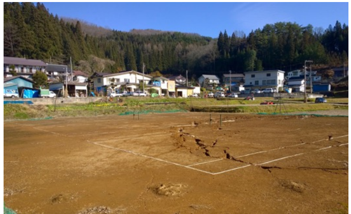
写真32 グラウンドにできた大きなひび割れ
