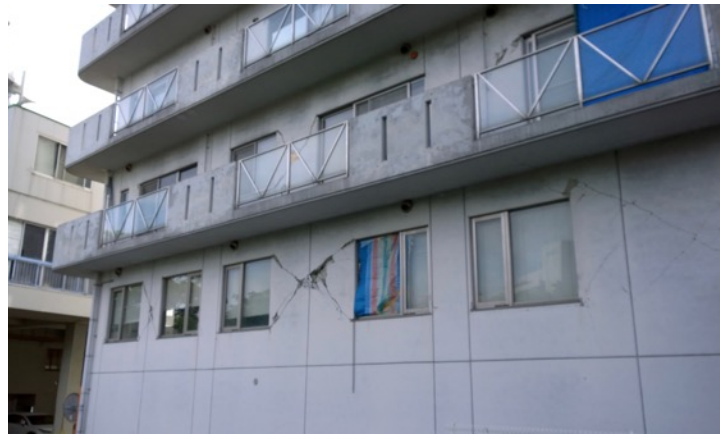
写真28 白川沿いのマンション
