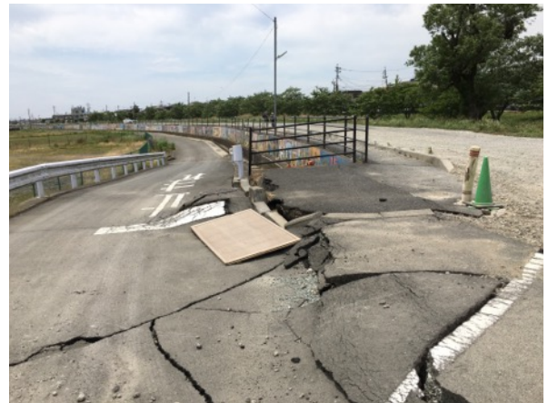
写真10 秋津川沿いの土手（道路段差）
