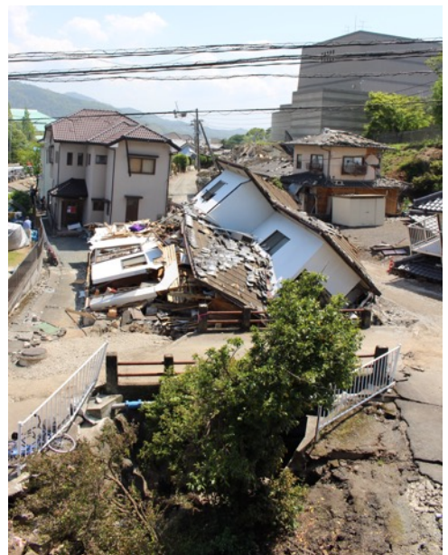
写真1 河川に向かって倒れ込んだ住宅 (寺迫交差点付近の河川敷)
