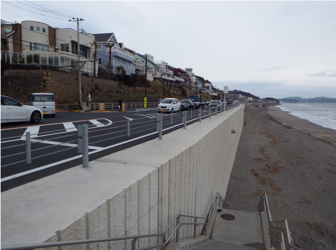
右側の車道の通行止めをほぼすることなく、進められた堤防の強化工事。工事は堤防の幅で行われ右側の砂浜への影響も少なかった
