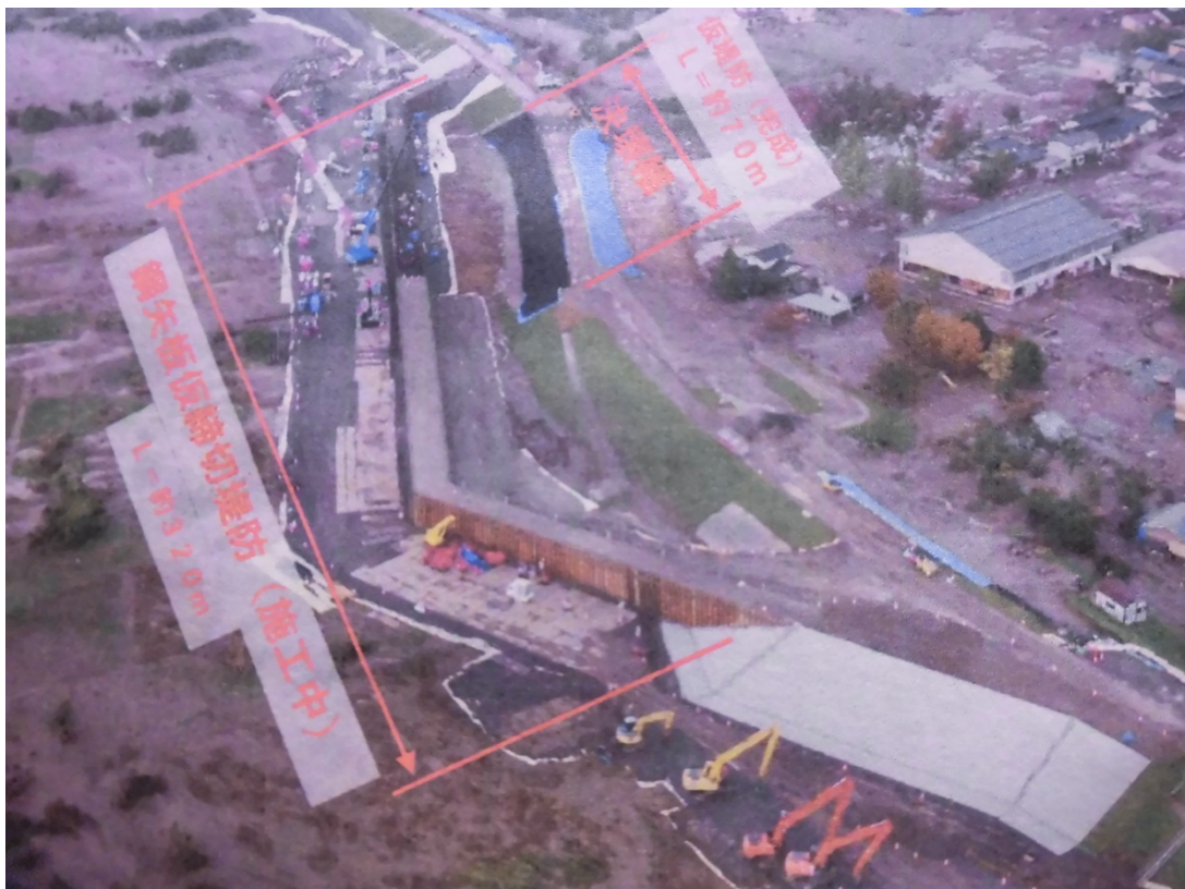
千曲川の堤防仮復旧工場の現場。右上が従来型の土堤防、左下方が新技術のインプラント堤防
