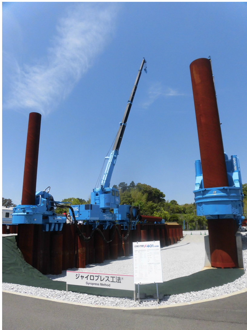
技研製作所が一般公開し始めた同社開発の杭打機による「壊れない堤防」の工法
