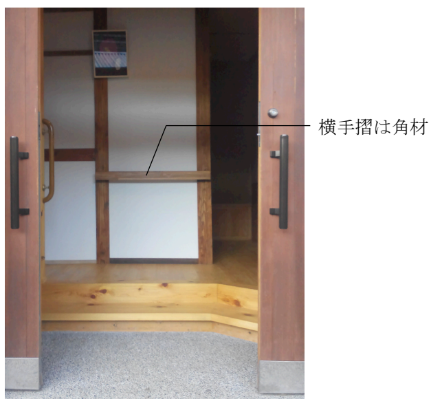
ただの角材だが横手摺には充分使える
