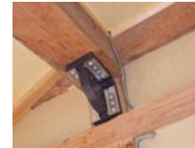
耐震リング 天井を押上げて露出で取付
