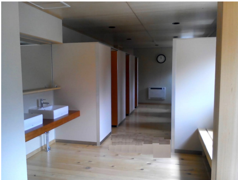
掃除流しと掃除用具は トイレブースの奥に設置
