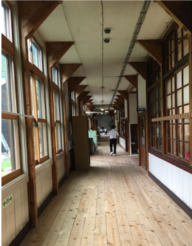
磨いて補修されたヒバの床板
