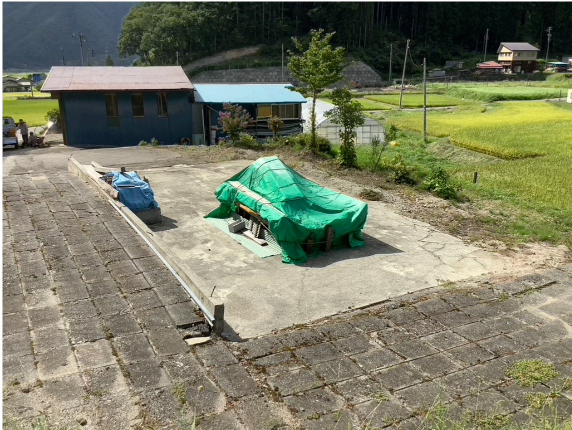
緑のシートの部分に作業小屋が建っていて、右側の田んぼに転がった。 正面の小屋は単管パイプを組んだだけのものだが、全く被害がなかったという。
