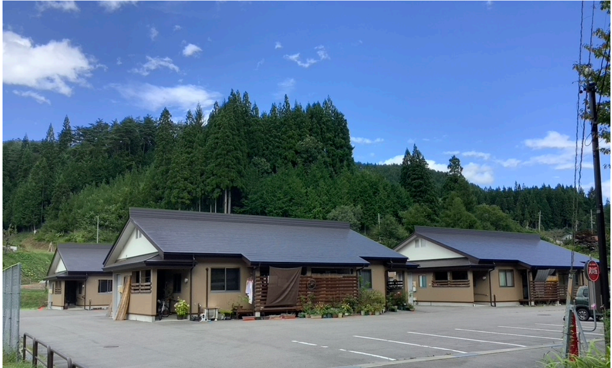
村営住宅:1棟に二世帯が入居(堀之内地区には二ヶ所、計14戸分建てられた)
