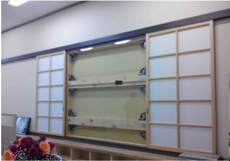
校長室に設けられた耐震補強(耐震リング)展示窓
