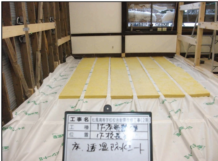
床断熱工事 グラスウールボード 60mm
