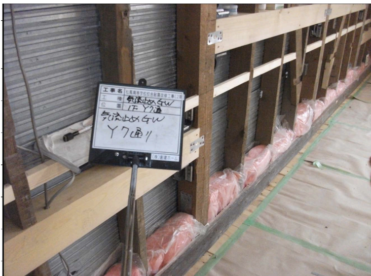
床と壁のコーナーは 気流止めで連続性を確保
