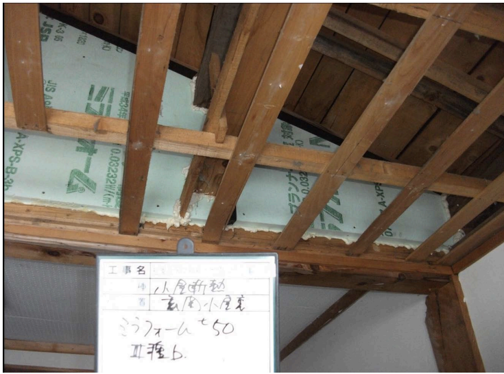
下屋部分の細部は ポリスチレンフォーム で連続性を確保
