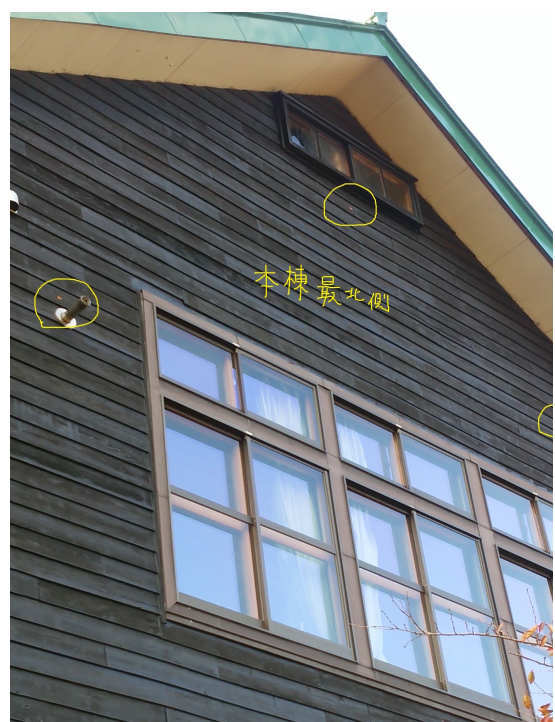
断熱材施工後の外壁
